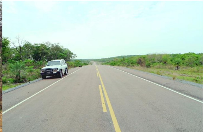
图 21: 现在，那里有一条通往 Valle-Mi 的新路。巴拉圭唯一的水泥厂就在那里。
